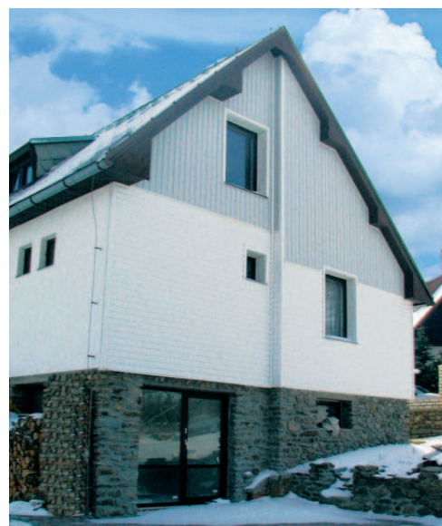
Aplikace vodorovných lamel D 4 D v kombinaci se svislou lamelou D 5 V při zateplení rodinného domu .
