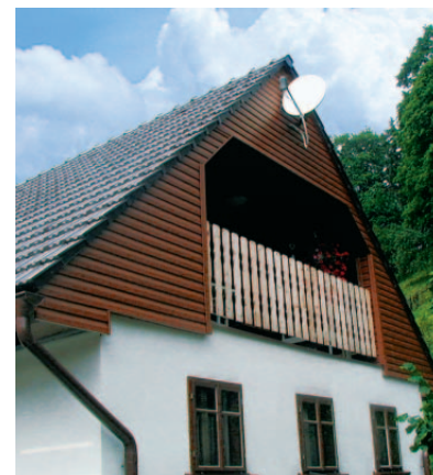
Těžko dostupná místa, zateplení štítů u nově vybudovaného obytného podkroví a pod.
