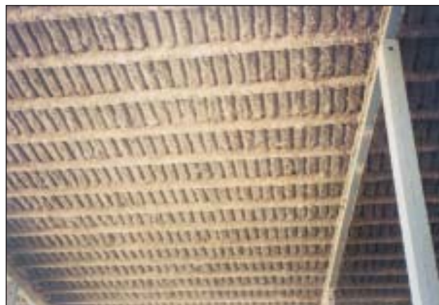
Protikondenzační nástřik tepelné izolace.
