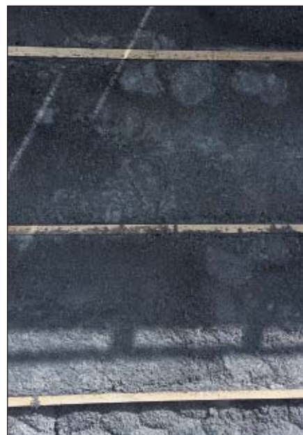
Finální úprava izolační vrstvy před montáží následných prvků systému.
