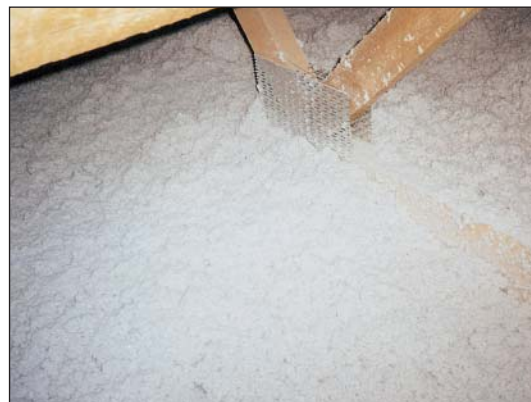
Climatizer Plus je v kvalitě zateplení detailů konvenčními materiály jen těžko dostižitelný.
