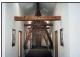
Půdní vestavby (Pražská tržnice)
