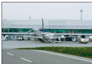
Zateplovací a protikondenzační nástřiky (venkovní pohled terminálu letiště Praha)
