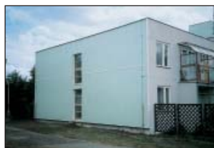
Panelová výstavba (domov seniorů Bohnice)
