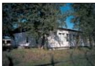
Zateplování průmyslových hal (Stavby mostů Toušeň)
